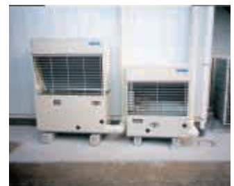
冷凍・冷蔵設備用の冷凍機
