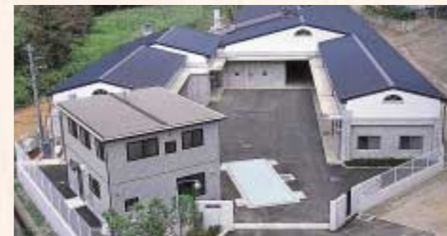
千葉県船橋市【堆肥化】 【フジフーズ(株)船橋・船橋第2工場:委託処理】 生ごみは破砕・脱水・乾燥処理後、70日間の発酵で堆肥化。製造された堆肥は堆肥化施設近隣の梨園農家等にて使用されています。
