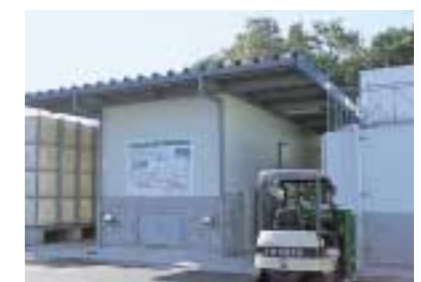
生ごみ減量プラント(所沢工場)
