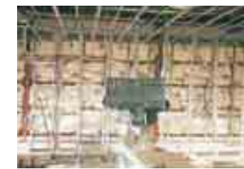
一般工法 ×作業者の技量や影響を受けやすい ×断熱効果が不安定 ×いろいろな資材が必要で作業工程が多い
