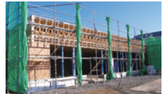
建設中の木造建築のお店
