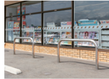
店舗駐車場に設置したガードパイプ
