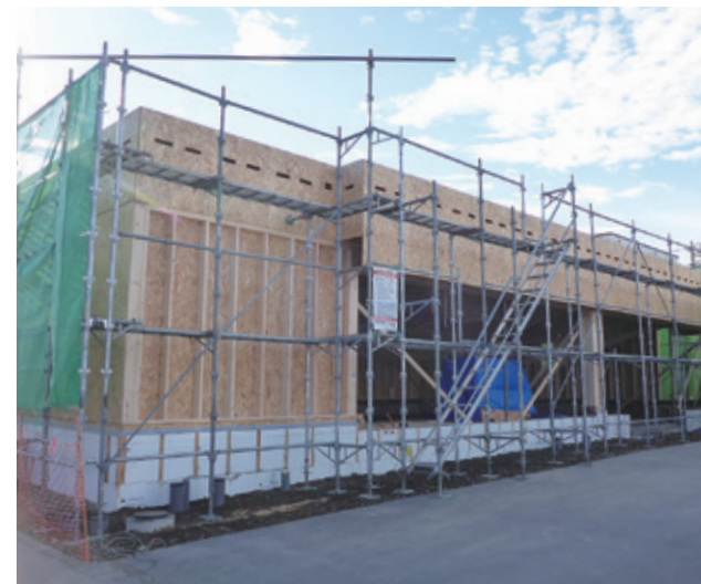
建設中の木造建築の店舗
